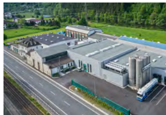
Plettenberg-Ohle Production Site Lennestraße 2 58840 Plettenberg
